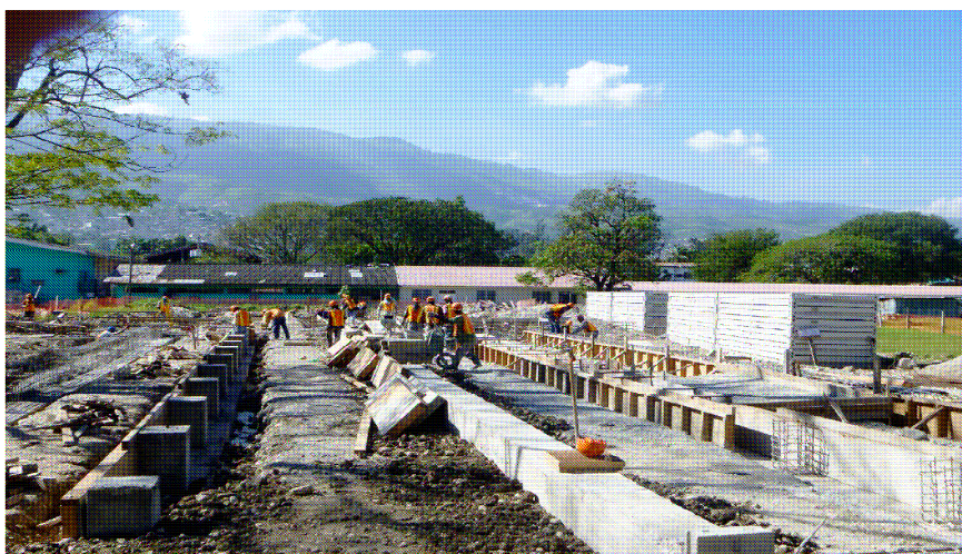
Travaux de fondation
