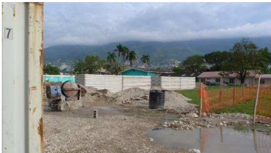
Livraison des containers
